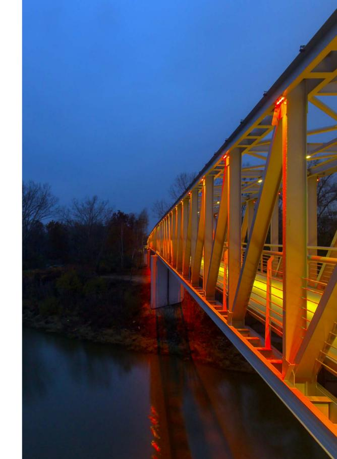
Der über 300 Meter lange Rad- und Fußgängerweg wurde dazu gebaut, um eine degradierte Fläche zu sanieren. Die Installation beinhaltet den Einsatz von linearen RGB-Produkten mit elliptischer Optik an der Außenseite der Struktur, die - über eine von Platek entwickelte Steuerung - ferngesteuert werden, um die Programmierung spektakulärer Lichteffekte anlässlich wichtiger
